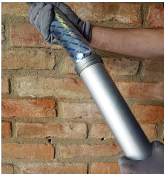
Priprema Mapestop Cream-a u pištolj za aplikaciju
