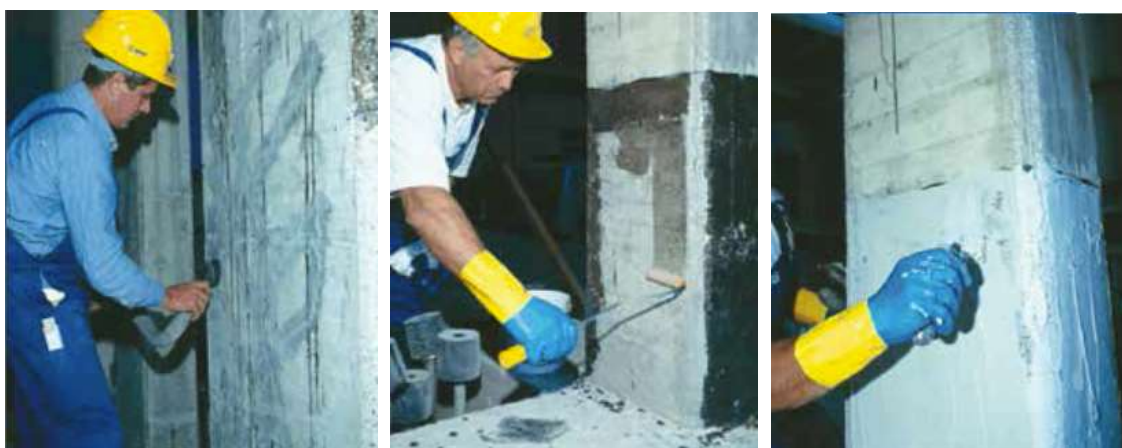
Priprema površine, nanos MapeWrap Primer 1 i nanos MapeWrap 11 ili 12 (s lijeva na desno)
