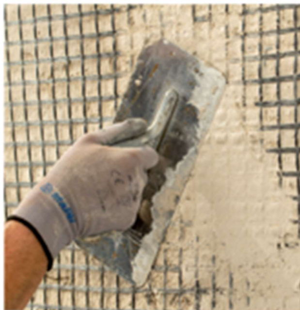
Prikaz postupka izvedbe FRCM-a na svodovima
