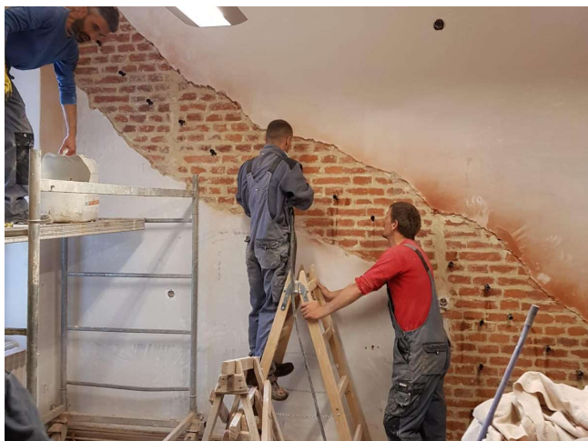
Prikaz postupka injektiranja zidova
