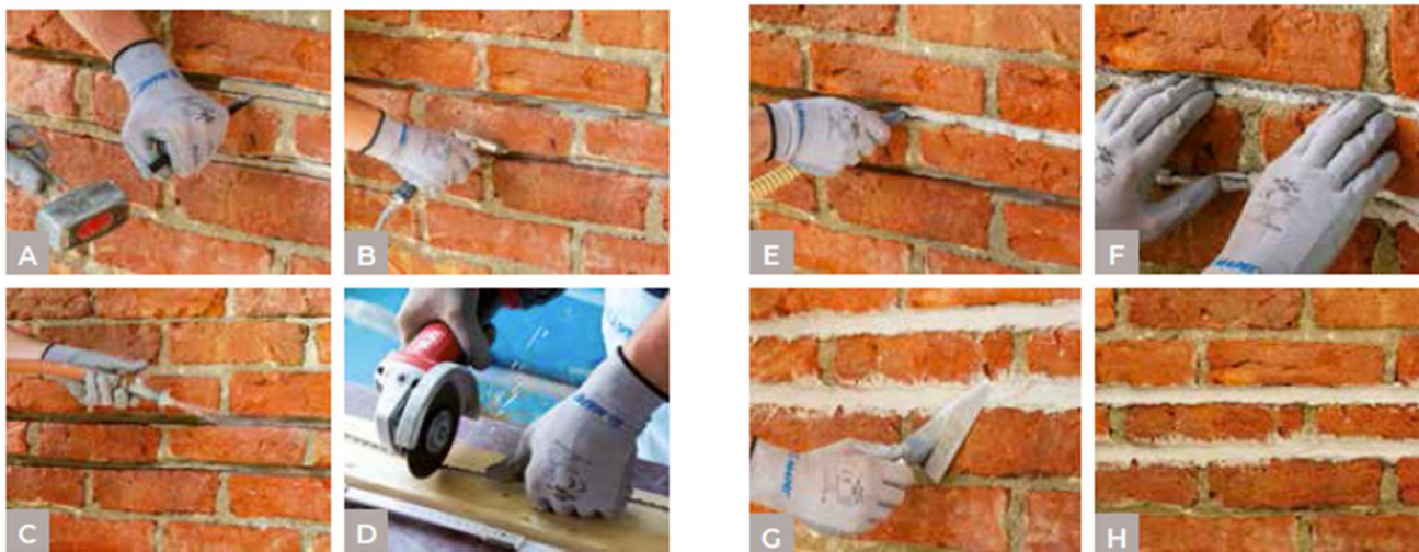
Prikaz postupka izvedbe polaganja šipki u sljubnice zida
