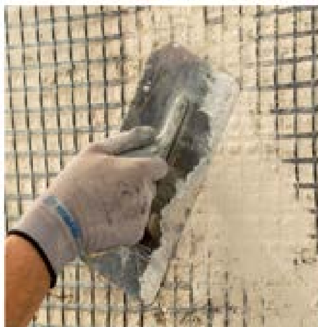
Prikaz postupka izvedbe FRCM-a na svodovima
