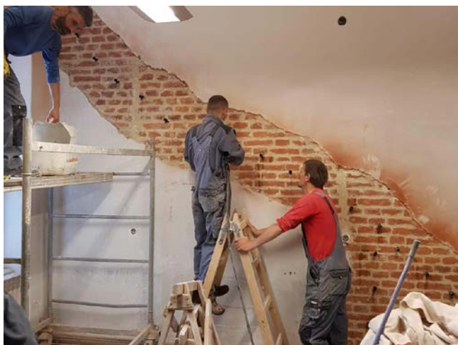
Prikaz postupka injektiranja zidova
