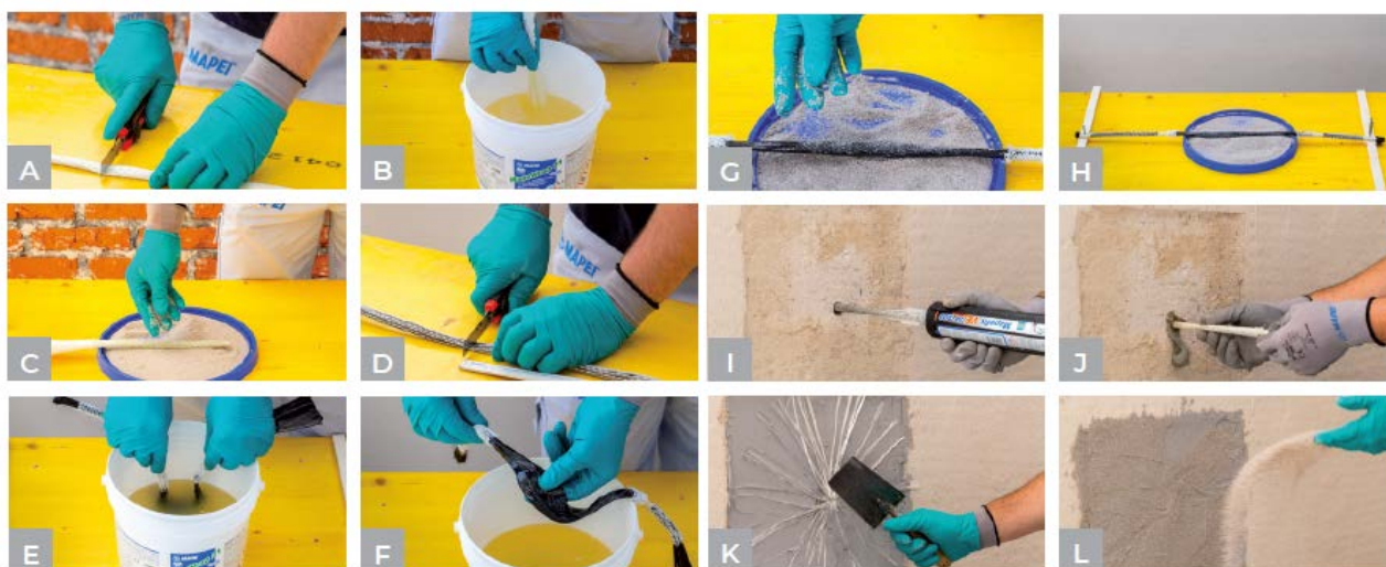
Postupak pripreme i izvođenja FIOCCO užadi
