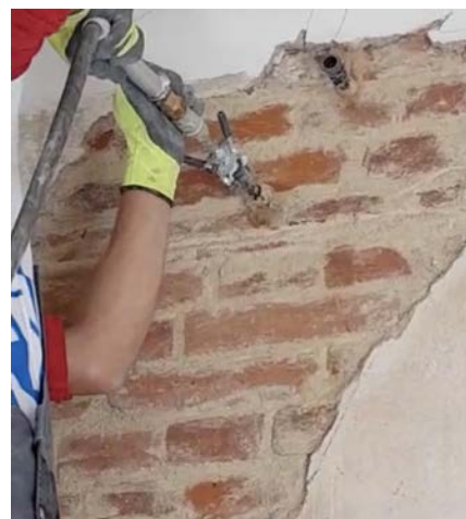
Prikaz postupka injektiranja zidova
