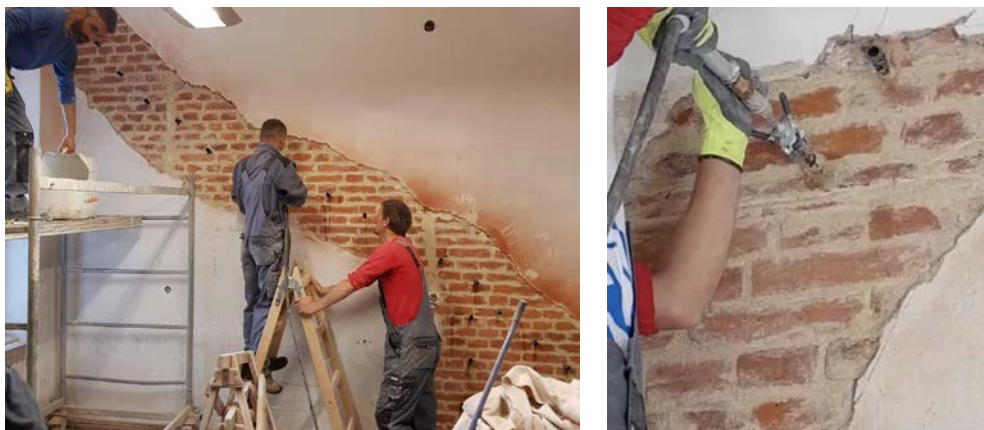
Prikaz postupka injektiranja zidova
