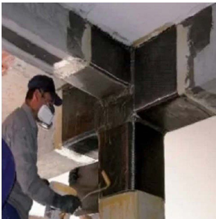
Izgled spoja greda i stupova
