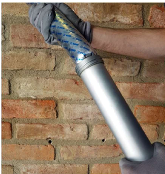
Priprema Mapestop Cream-a u pištolj za aplikaciju
