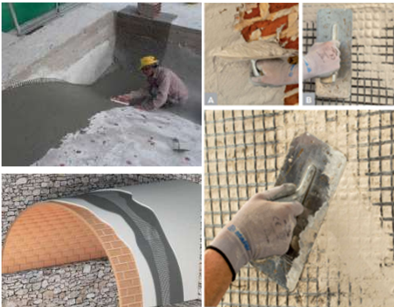
Prikaz postupka izvedbe FRCM-a na svodovima
