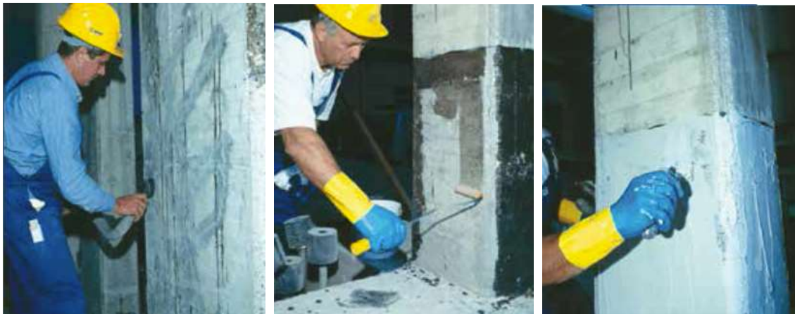
Priprema površine, nanos MapeWrap Primer 1 i nanos MapeWrap 11 ili 12 (s lijeva na desno)
